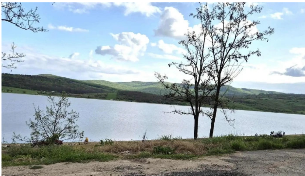
Barajul puscasi aproape de mine
