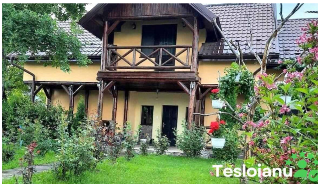
Ferma de la casva exterior
