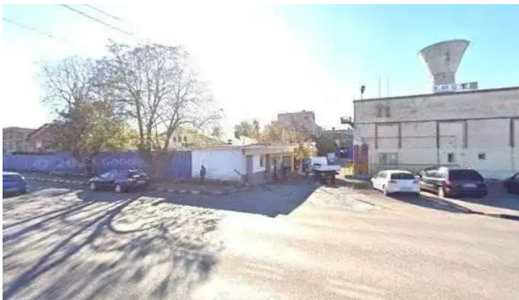
Instalatii mecanice si utilaj tehnologic street view si 360deg
