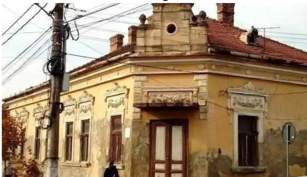
Ocna mureș ocna mureș
