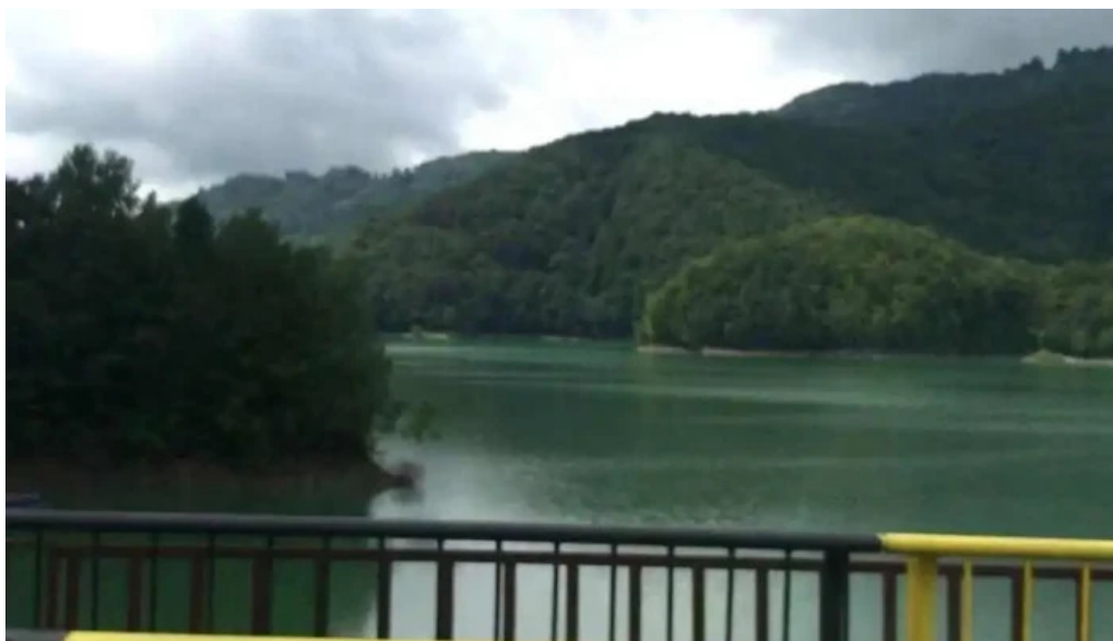
Popas viaduct videoclipuri
